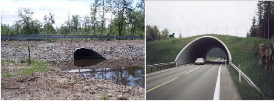
Figur 1:2 Till vänster ett fotografi på en lågbyggd rörbro över ett vattendrag, taget av WSP Samhällsbyggnad Till höger en animerad bild på en valvbåge som bildar en vilt passage över väg.
