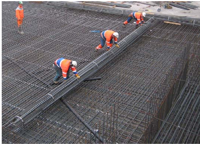
Figur 3.3, Utläggning av rullarmering ( Celsa Steel Service, 2007 )
